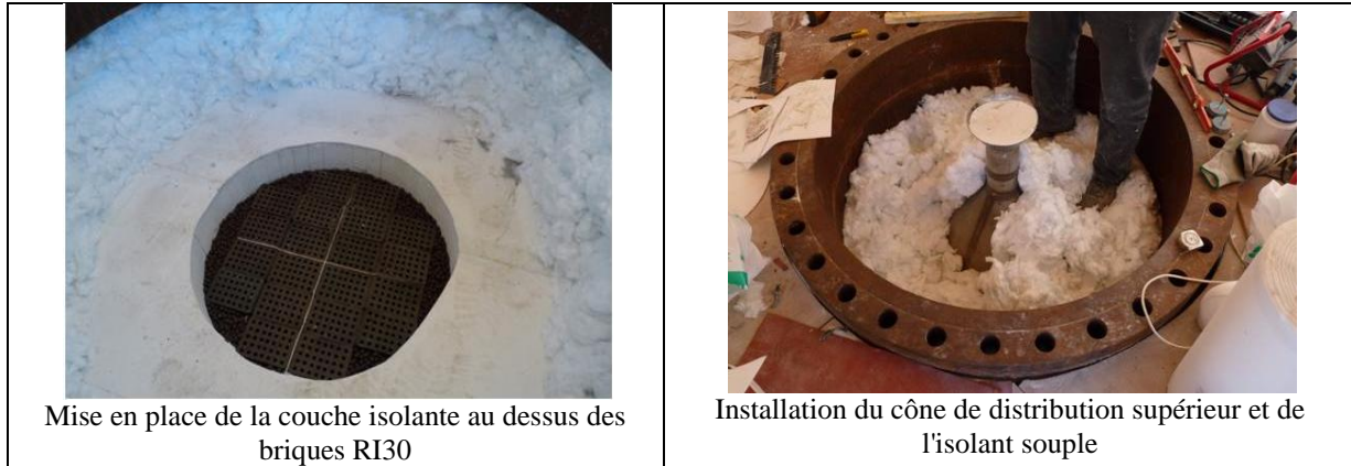
Figure 4.4 : Etapes de préparation de l'enceinte pour les essais (CEA/LITEN)
