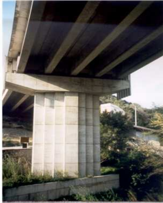
Figure 7-1 Vue du viaduc de Fozière
