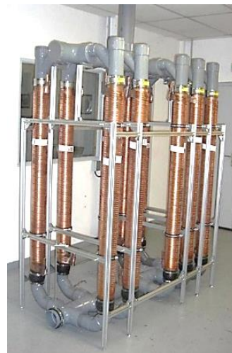
Figure 32: Exemple d'installation de "Power Pipe"
