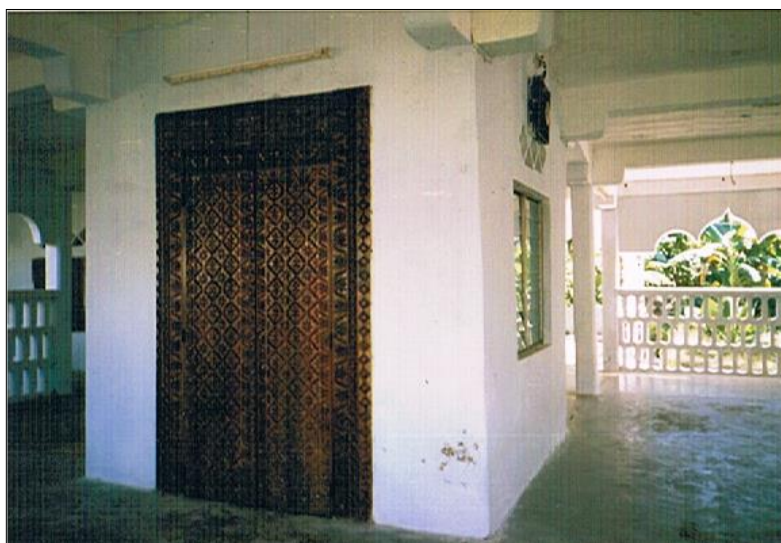
Photo 94 : La porte d'entrée de la Zawiya de Cheikh Soilihi. Celle-ci vient d'être restaurée pour garantir la sécurité des fidèles, car la terrasse commençait à se détériorer. Source : Bourhane Abderemane – prise en 2012
