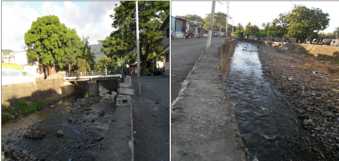
Les deux photos 90 (à gauche) et 91 (à droite) : Montrent la digue construite à l'époque coloniale après l'inondation de décembre 1951, pour protéger le quartier de Kilingeni (à droite de la photo 14) et une autre digue, construite dans les années 2000 protège le quartier de Kardjavindza en aval de la rivière là où il y a beaucoup d'arbres.
