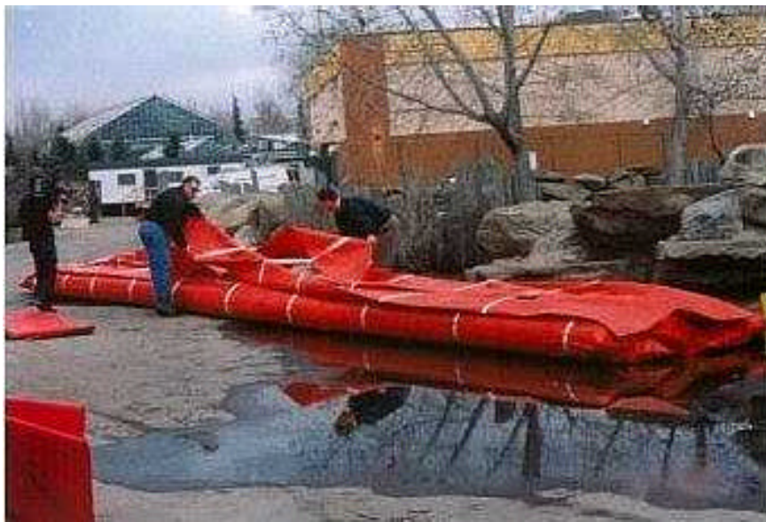
FIGURE 4.4.7 STRUCTURES TUBULAIRES REMPLIES D'EAU : INSTALLATION DU SYSTÈME « CLEMENT »
