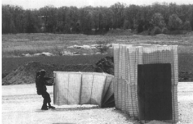
FIGURE 4.1.3 INSTALLATION DU CONCERTAINER HESCO: ÉTIREMENT DE LA CAGE
