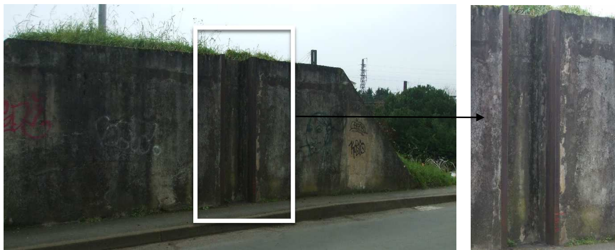
Figure 29: rainures métalliques pour y disposer les batardeaux (ouverture rue du Docteur Zamenhoff).
