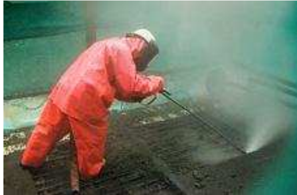
Illustration 6 : Démolition par jet d'eau à haute pression (hydrodémolition), http://www.buxtons-water.co.uk/
