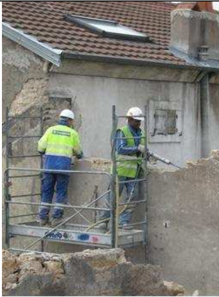
Illustration 7 : Démolition manuelle par dérasement, http://www.sned.fr
