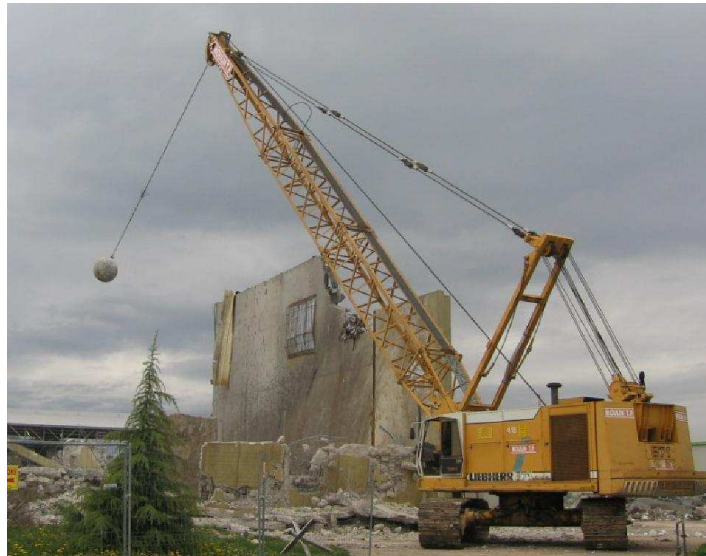
Illustration 2 : Démolition au boulet de démolition, http://technique-tp.leforum.eu/
