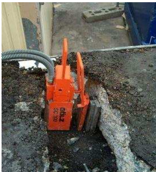
Illustration 5 : Procédé de démolition par dislocation, http://www.tst67.fr/
