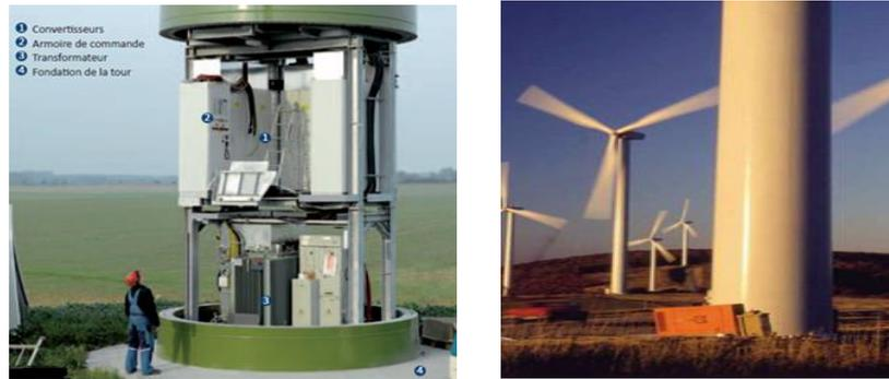
Fig. I. 18. La tour éolienne et ses composants électroniques à l'intérieur.
