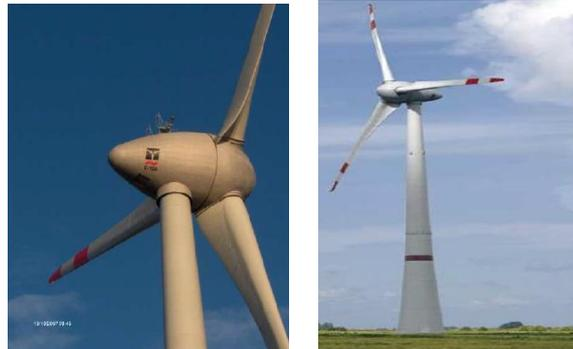
Fig. I. 16. L'éolienne E126 de 7.5MW d'ENERCON (Allemagne).
