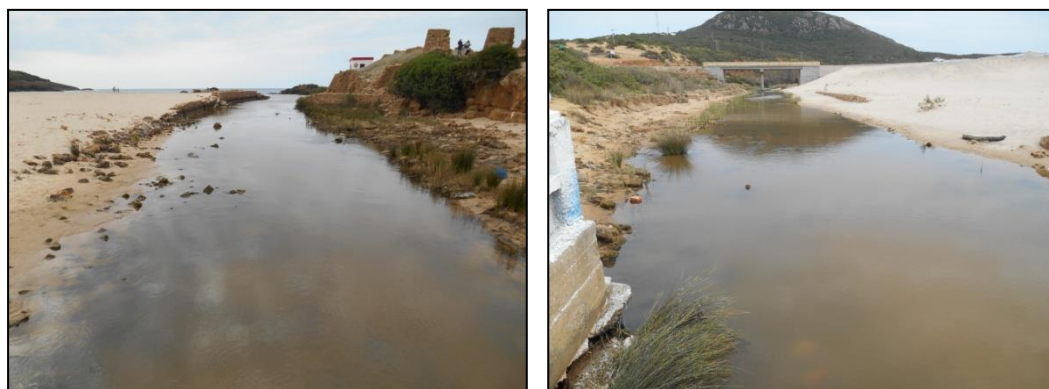
Figure 12 : Canal Messida (Photos prises le : 23/05/2014).
