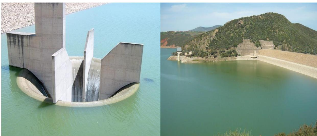
Figure 45 : Evacuateur de crue et digue du barrage de Bouhamdane
