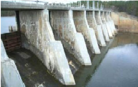
Figure I.2 Réservoir d'eau du Barrage du lac Randleman atteint de l'ASR, Canada [Calv, 2013].
