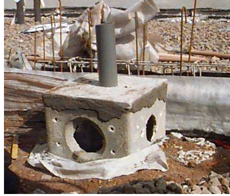
Figure 4.10 : mise en place d'un puisard.
