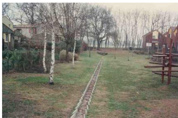
Figure 1.12. Noue équipée d'une cunette béton pour évacuer les eaux stagnantes (photographie du Centre d'études techniques de l'Équipement (CETE) du Sud-Ouest, extraite de Régions Aquitaine et Poitou-Charentes (2007))
