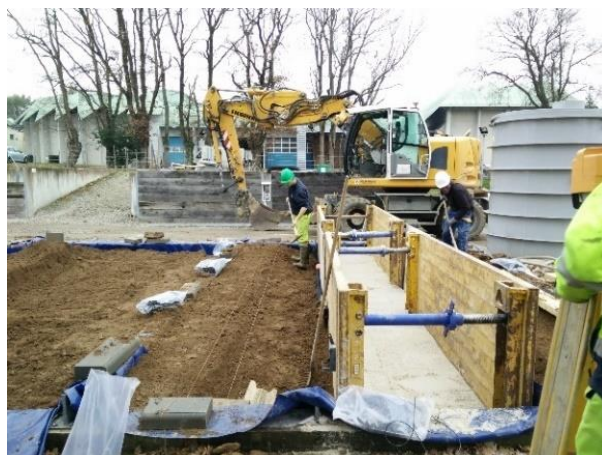
Figure 3.6. Blindage de tranchées utilisé pour monter la partie centrale de la noue de filtration
