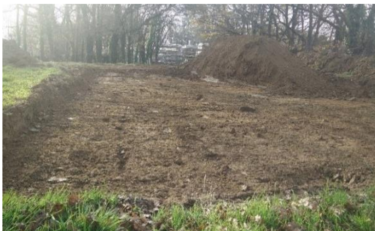
Figure 3.5. Remblai excavé au CSTB, utilisé pour construire la noue standard et les talus de la noue de filtration
