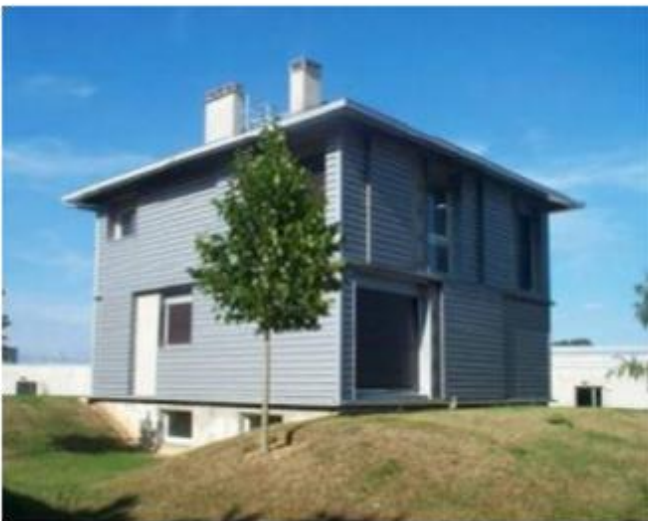
(a) Vue extérieure.
