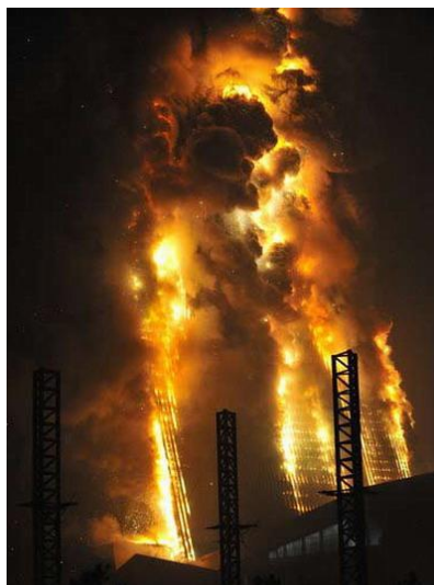
Figure 1.3-6: Incendie de la tour CCTV à Pékin.
