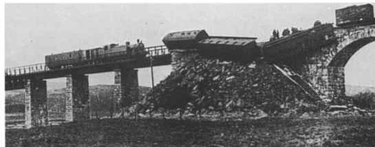
FIGURE 1.1 – Renversement d'un train sur le viaduc d'Owencarrow en Irlande, 1925.
