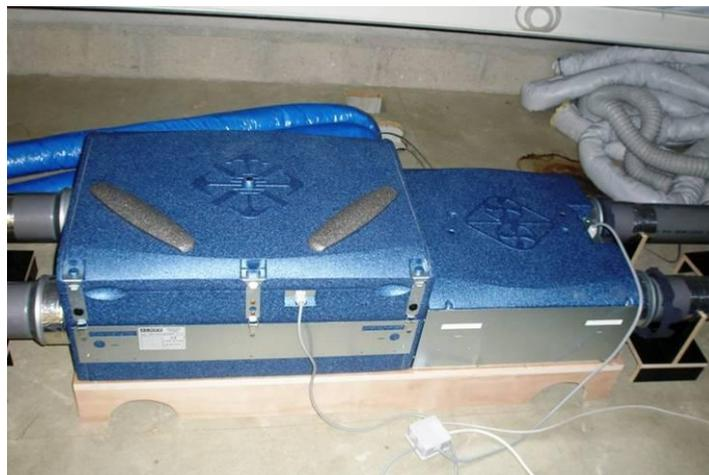
Figure 2.7 : Groupe de ventilation de la VMC double flux.
