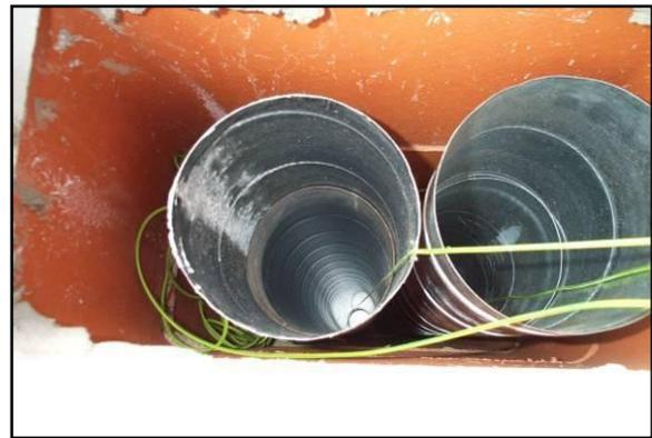
Figure 2.8 : Débouchés dans les pièces techniques et en toiture des conduits à tirage naturel.
