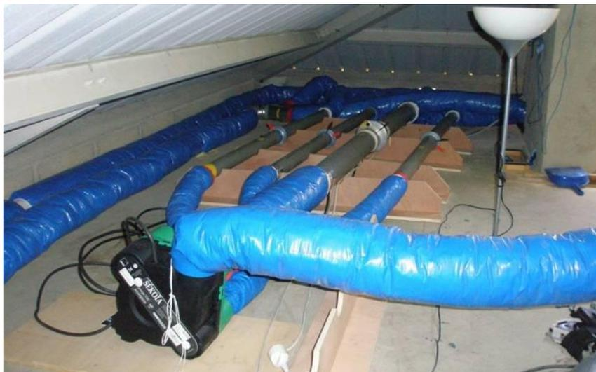
Figure 2.6 : Ventilateur de la VMC simple flux.
