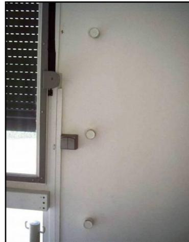
Figure 2.10 : Colonnes de trous calibrés sur les façades.
