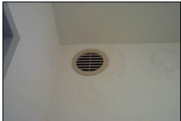
Figure 2.9 : Extracteurs statiques et grille d'extraction dans une pièce technique.
