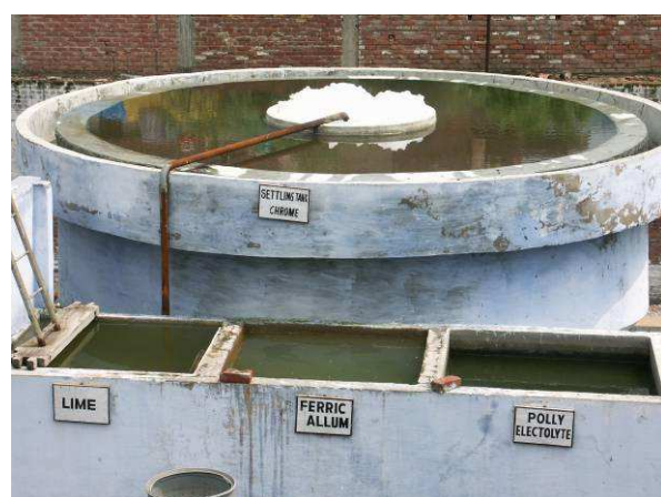
Traitement physico-chimique Super Tannery Limited , Jajmau, Kanpur, 4 août 2007
