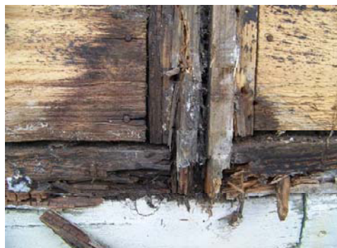
FIGURE 1.3 – Dégradation du bois due au passage de l'air exfiltré chargé de vapeur d'eau [Source : Enertech, Olivier Sidler]
