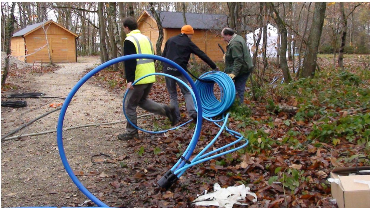
FIGURE 3.10 – Vue de la sonde coaxiale de 50 m lors de sa mise en place sur la plate-forme
