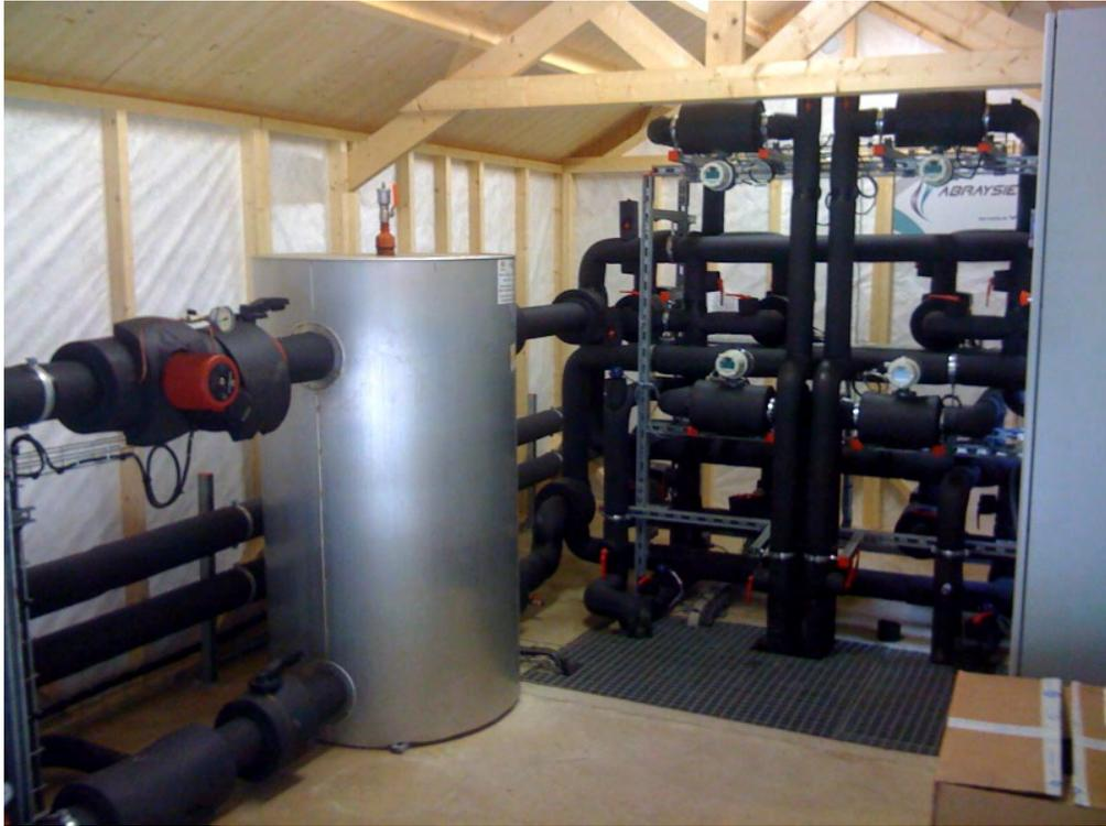
FIGURE 3.13 – Machinerie thermodynamique de régulation des échangeurs géothermiques
