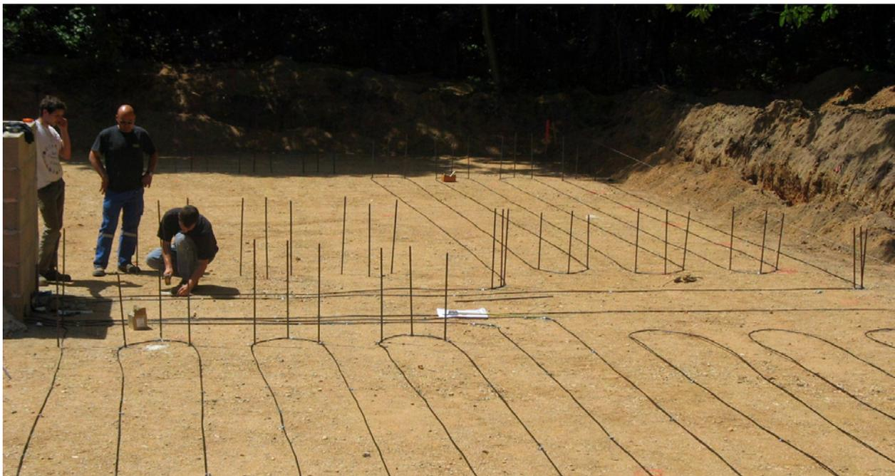
FIGURE 3.18 – Mise en place des fibres optiques à 1.5 m de profondeur
