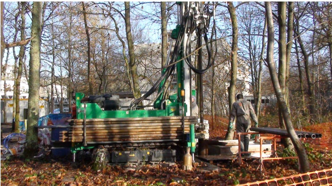
FIGURE 3.8 – Opération de forage au coeur du bosquet de la plate-forme expérimentale
