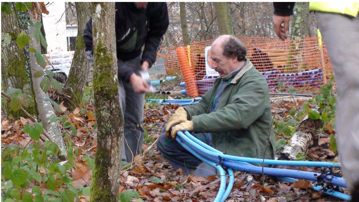
FIGURE 3.11 – Mise en place des écarteurs de tubes sur la sonde coaxiale
