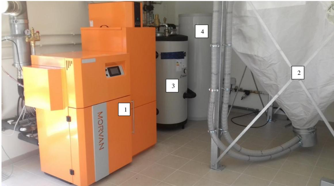
**Figure 21 : Installation d'une chaudière à granulés (1) avec Silo de stockage (2), un ballon tampon (3) et production d'eau chaude sanitaire (4) [107].**
