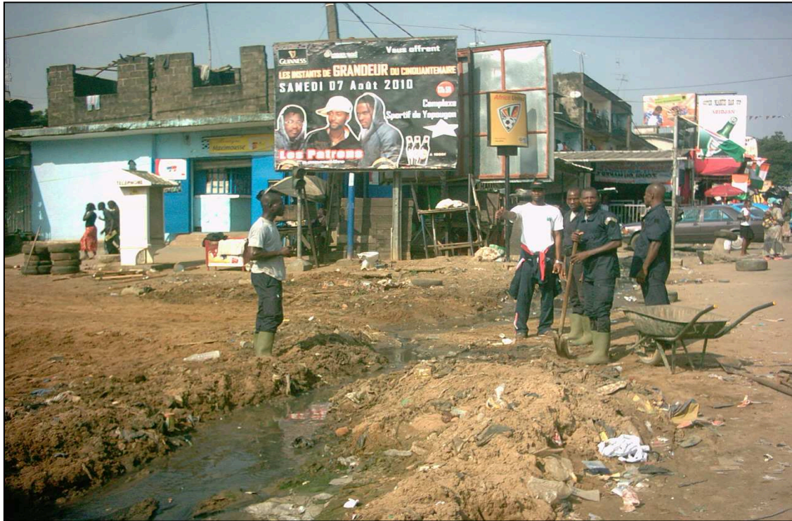
Photo n° 8 : La brigade de salubrité en plein travaux d'assainissement au niveau de l'ex-rue princesse à Yopougon. Photographie : Adomon, août 2010
