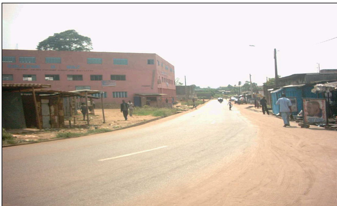
Photo n°2 : Voirie réhabilitée par la Mairie de Yopougon au quartier Andokoi. Cette voie passe par le 23eme arrondissement et donne accès à la zone industrielle. Photographie : Adomon, août 2010
