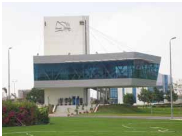
Figure n°5 : Le « pavillon », qui accueille les bureaux du Smart Village.
