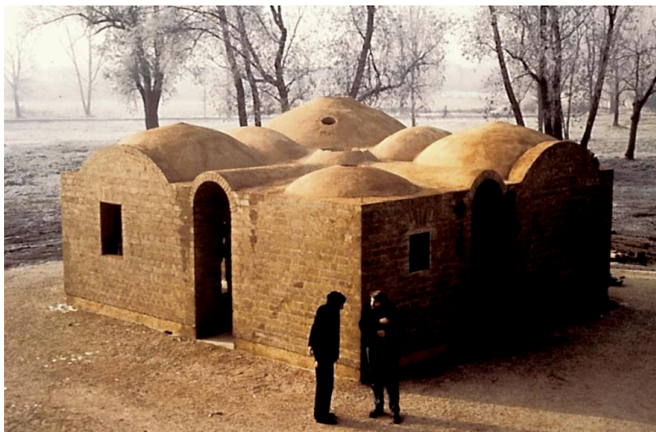
Edifice en terre crue construit à Grenoble en moins de 24 heures
