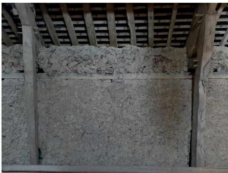
Photographie d'une charpente engagée dans un mur porteur en bauge au premier étage et à l'intérieur d'une dépendance d'une maison datant du XIXème en Bretagne. Photographie réalisée par Victor Villain en 2019.
