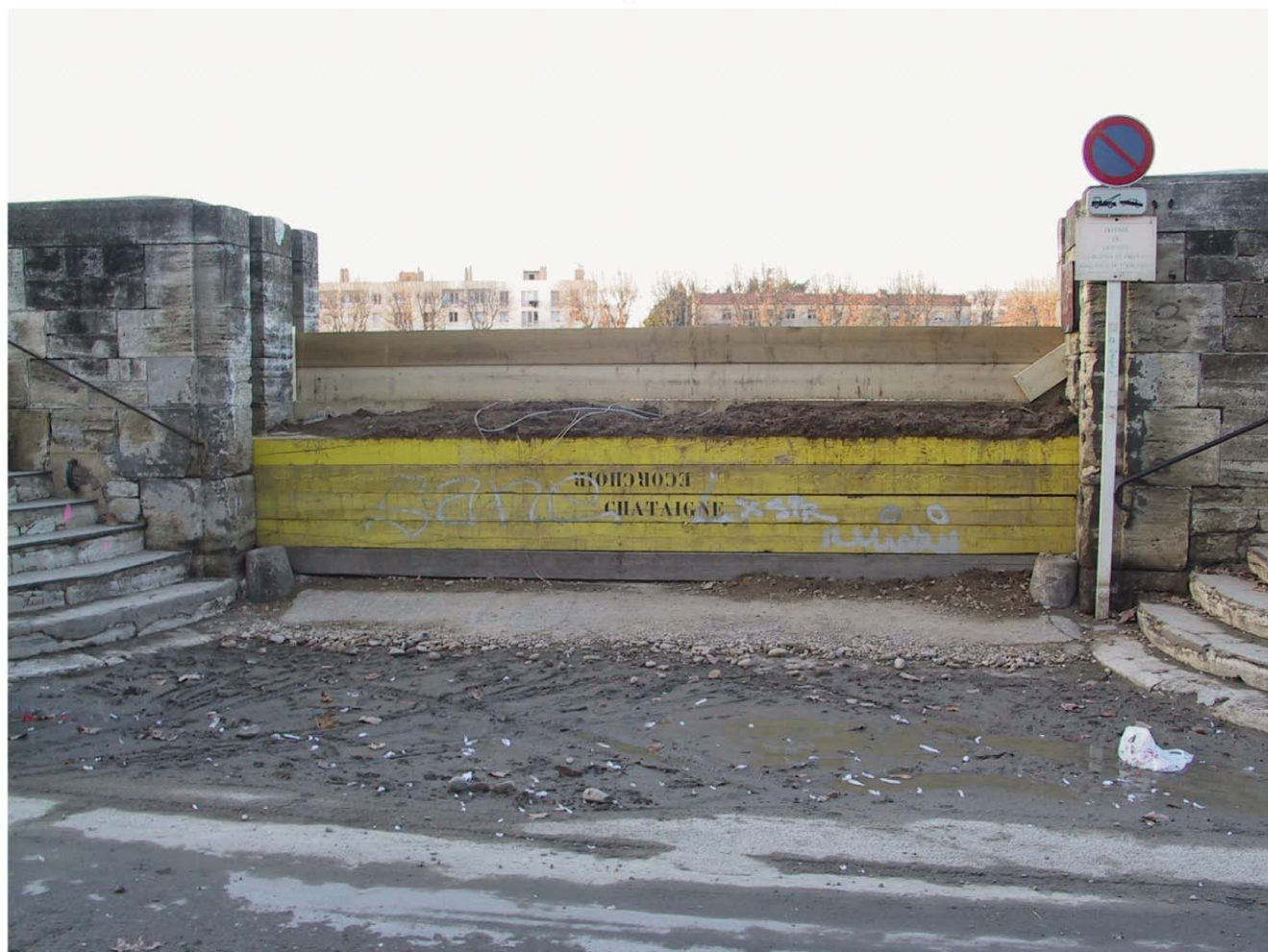
Figure 71. La protection des quais par les batardeaux
