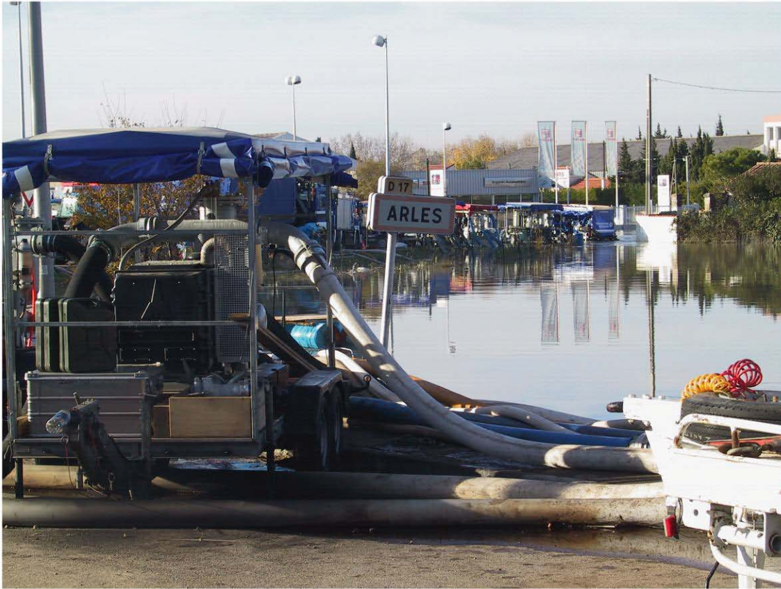
Figure 72. Les opérations de pompage des eaux du Trébon
