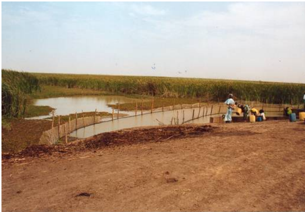
Figure 61 – Grille installée pour empêcher l'entrée de S. molesta dans le Parc du Djoudj, novembre 2000
