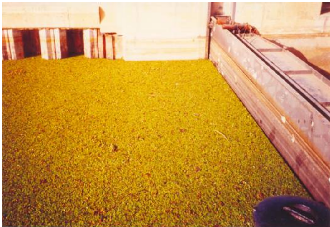
Figure 58 - Envahissement des écluses du barrage de Diama par S. molesta , Novembre 1999
