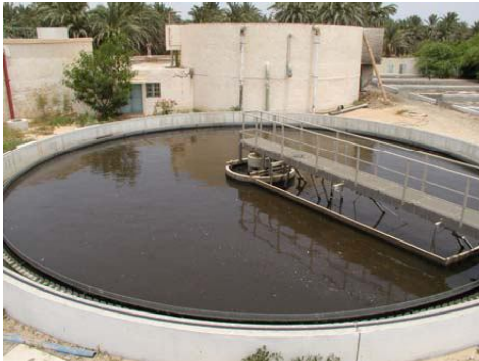
Figure N° 4 Vue du décanteur principal de la station d'épuration de Nouakchott
