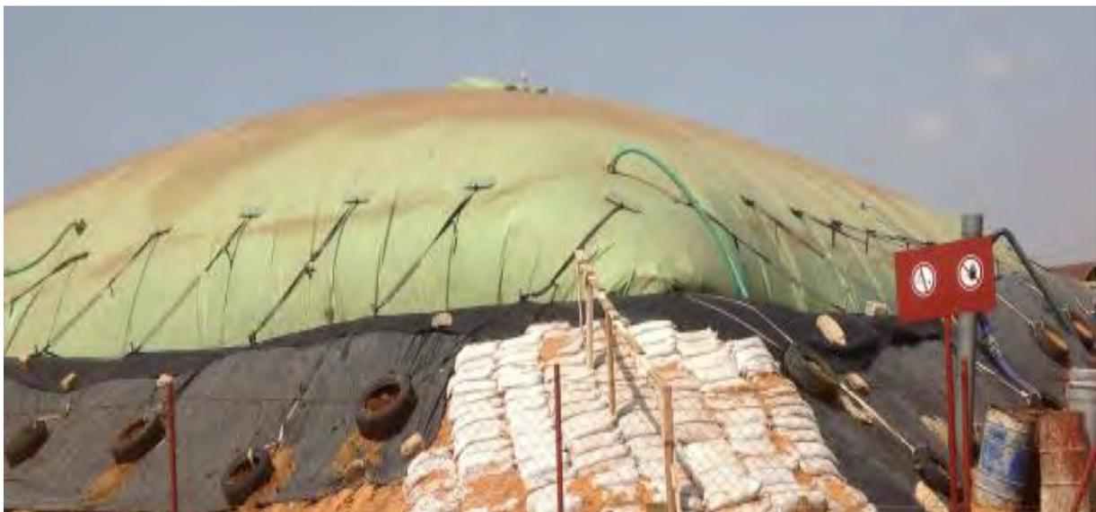
Figure I-3 : Digesteur de type ballon (SOGAS)
