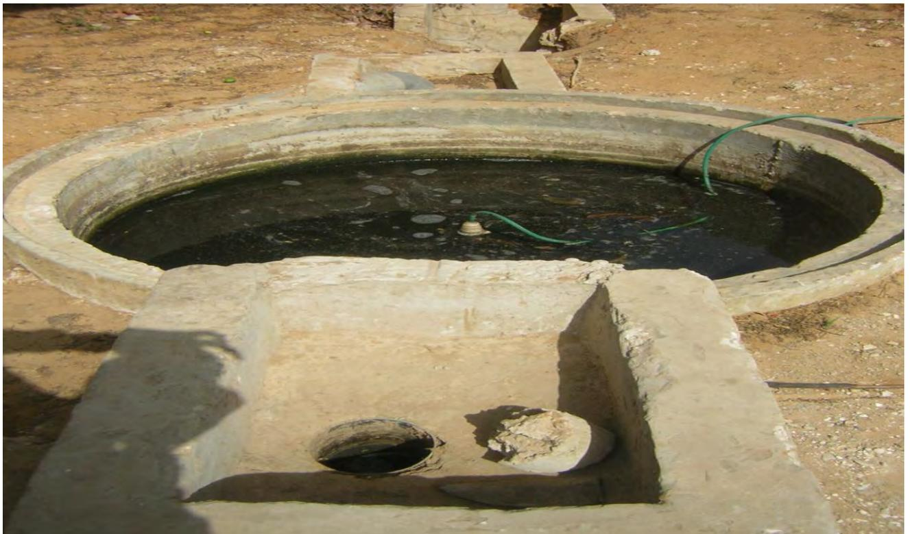
Figure I-6 : Digesteur fabriqué sur site (CERER)
