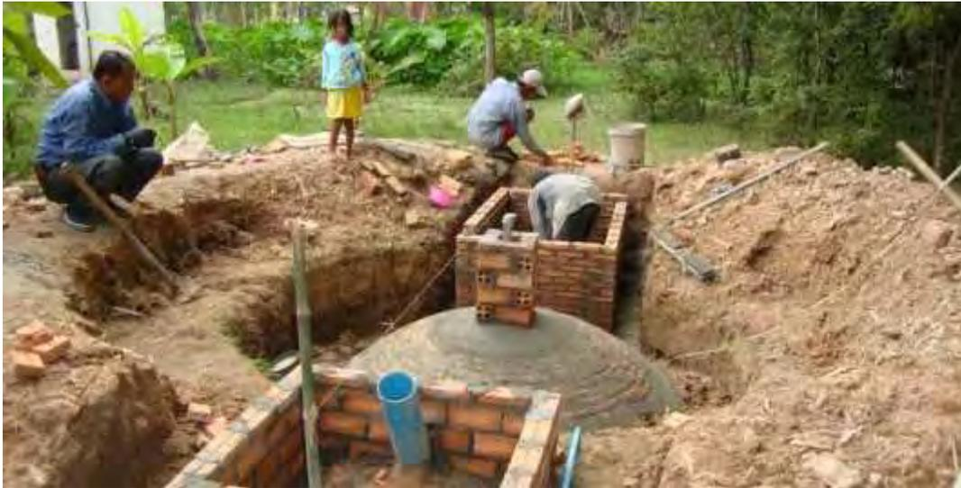
**Figure 3 :** Digesteur de type indien (Green et Vert, 2012)
