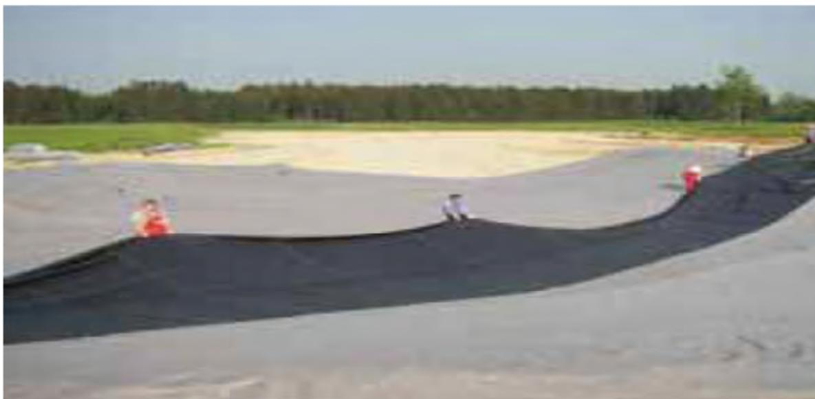
Figure 71: Pose des géo-membranes EPDM Firestone sur un chantier
