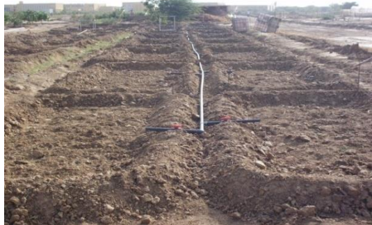
Installation du système d'irrigation (tuyauterie et vannes)
