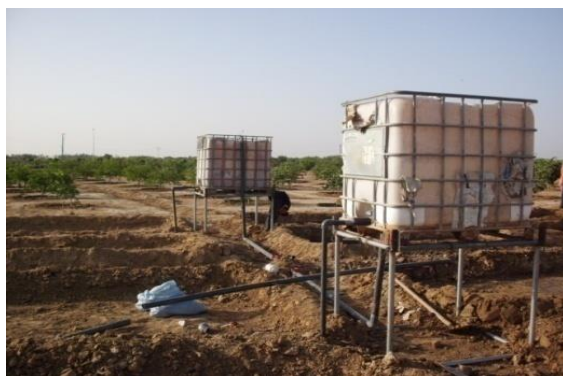
Installation et montage des bacs ( 1\text{ m}^3 ) qui vont contenir les eaux enrichies en NaCl destinées à l'irrigation des parcelles
