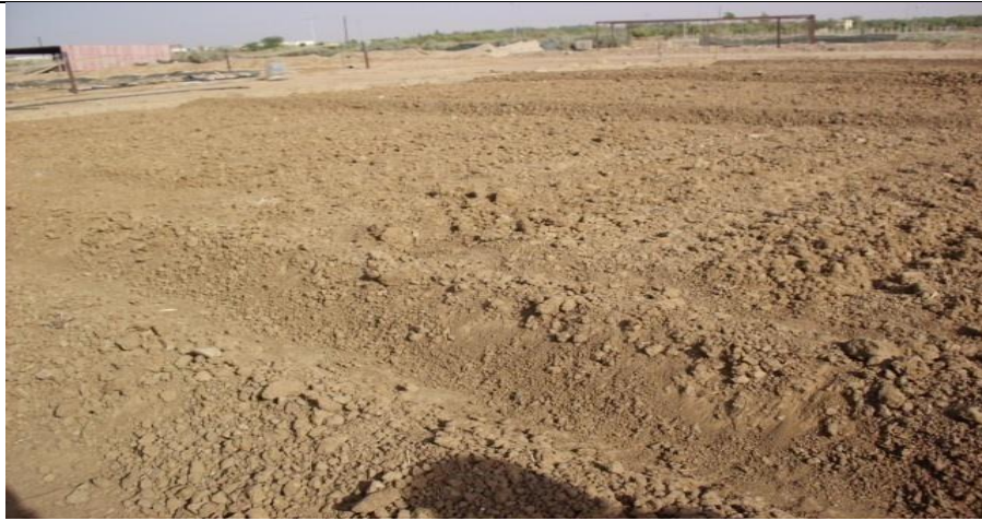
a) Terrain après travaux de sol (Offsetage)
