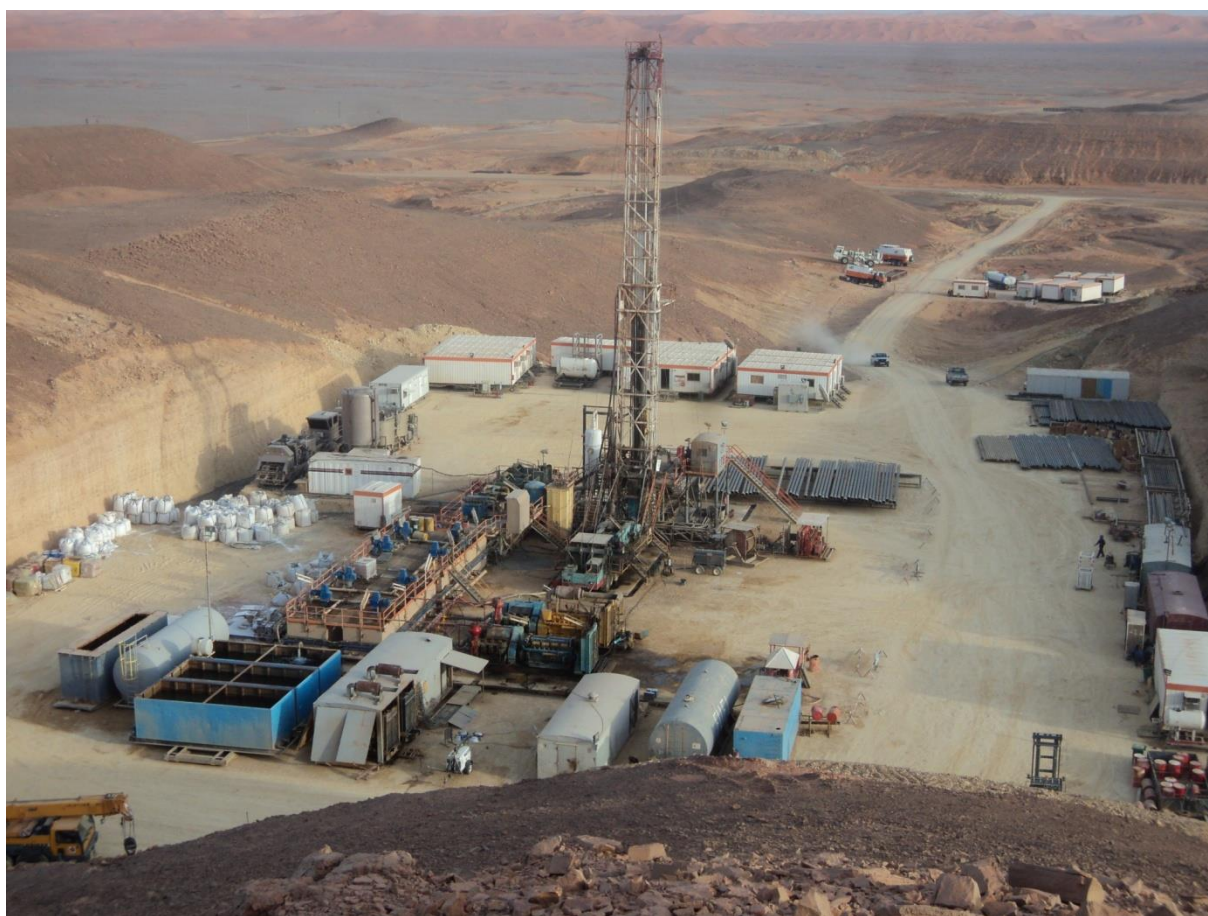
Photos d'appareil de forage
