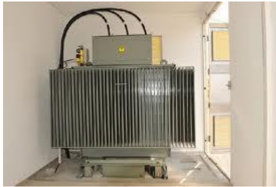
Figure 3.9 : Transformateur HTA/BT
