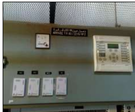
Figure III.16 : Relais de type numérique
