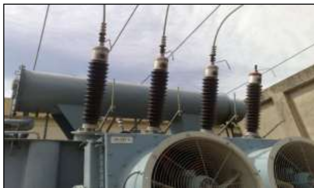
Figure III.11 : Éclateurs placés sur les pôles HT
