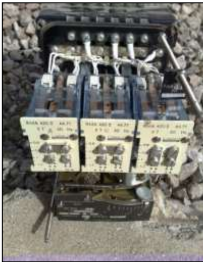
Figure III.15 : relais de type électromécanique
