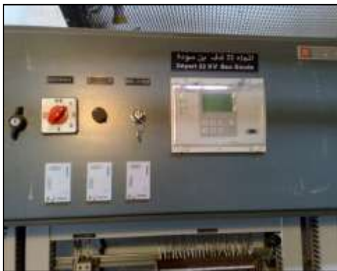
Figure III.16 : Relais de type numérique
