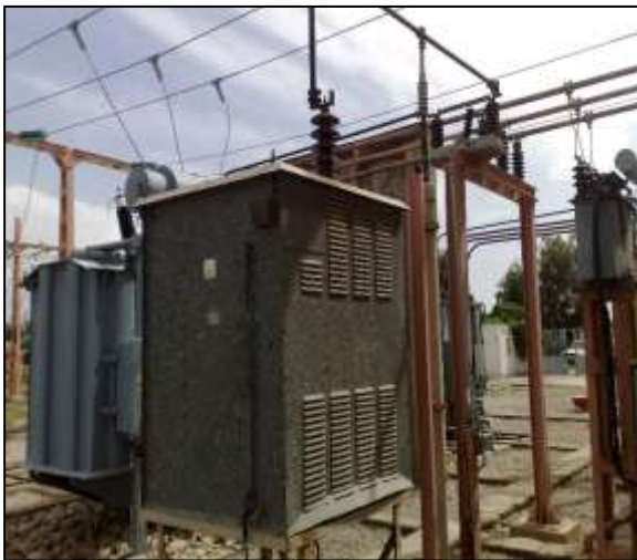
Figure III.13 : Résistance du neutre 42,5 \Omega Figure III.14 : Emplacement TC spécial 1/1 A
