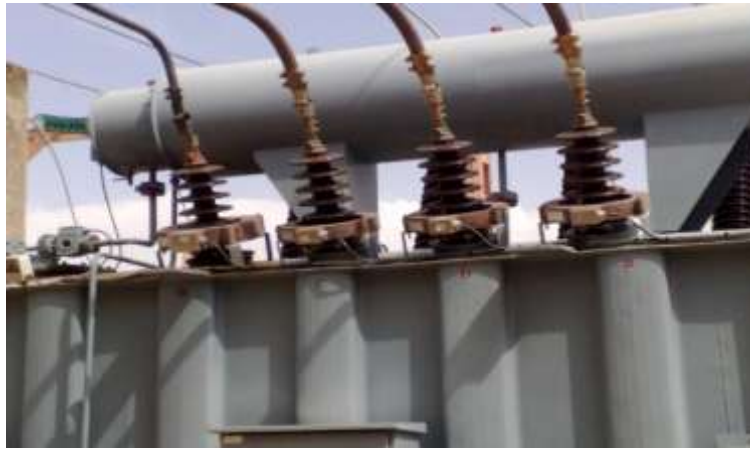
Figure III.12 : Emplacement des TC sur les pôles secondaires du transfo. HT/MT
