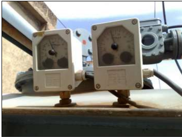
Figure III.7 : Dispositif de détection de température
