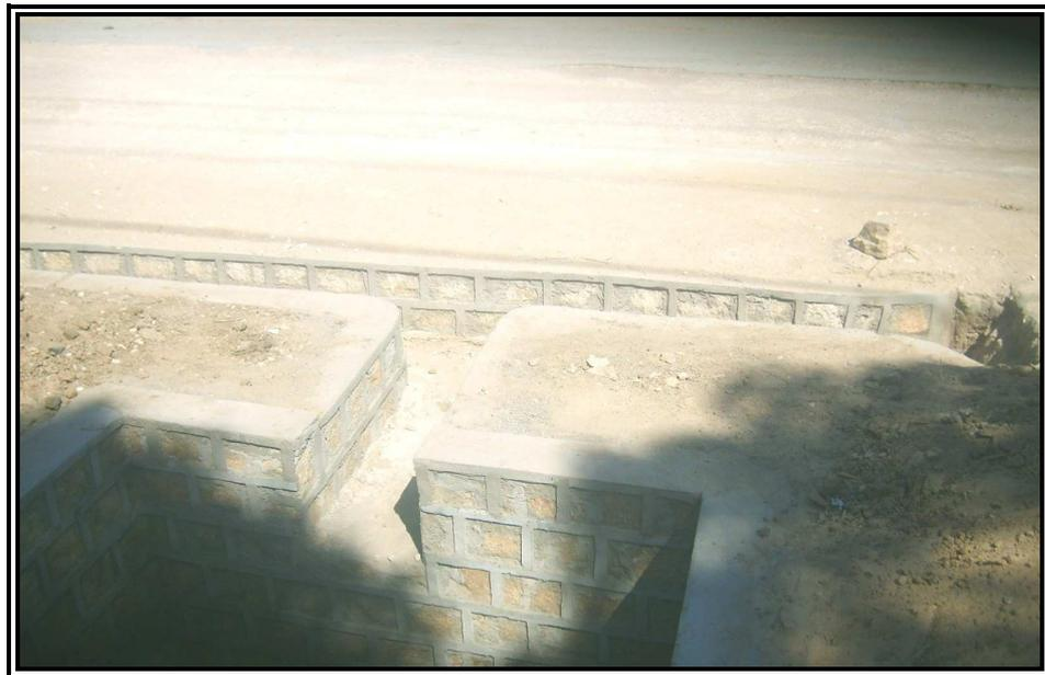
**Photo n° 4 :** Drainage des eaux pluviales sur la route de *Mitsinjo*. Les eaux pluviales sont collectées dans le petit bassin. Une simple pluie suffit pour remplir ce petit bassin.
