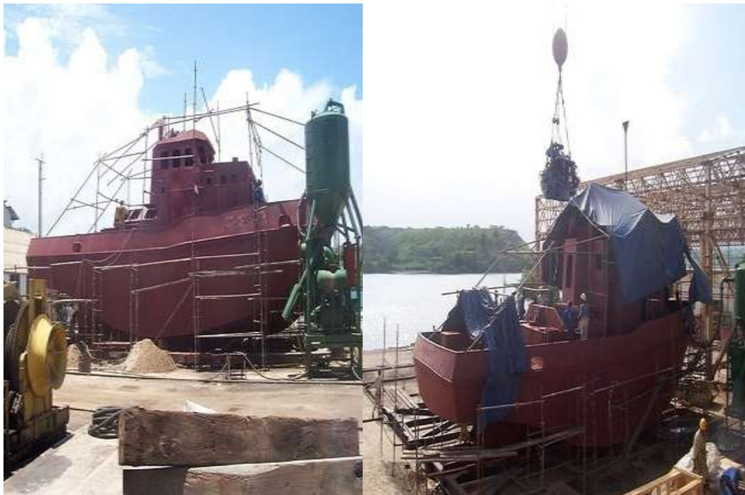
1-Construction de la vedette JAOLAHY
