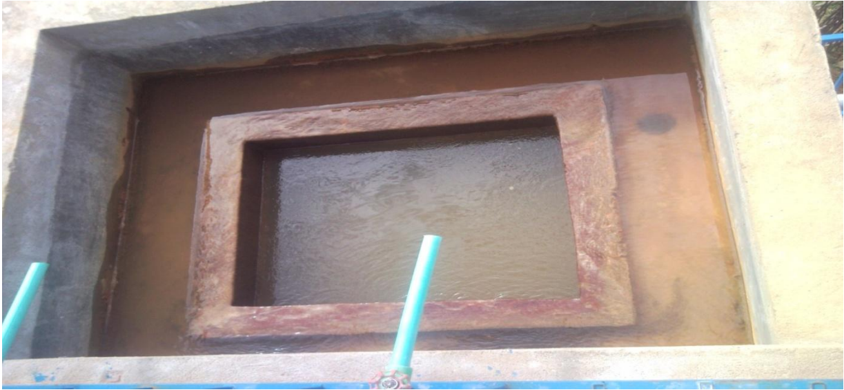
Photo n°7 : Bassin de filtration
