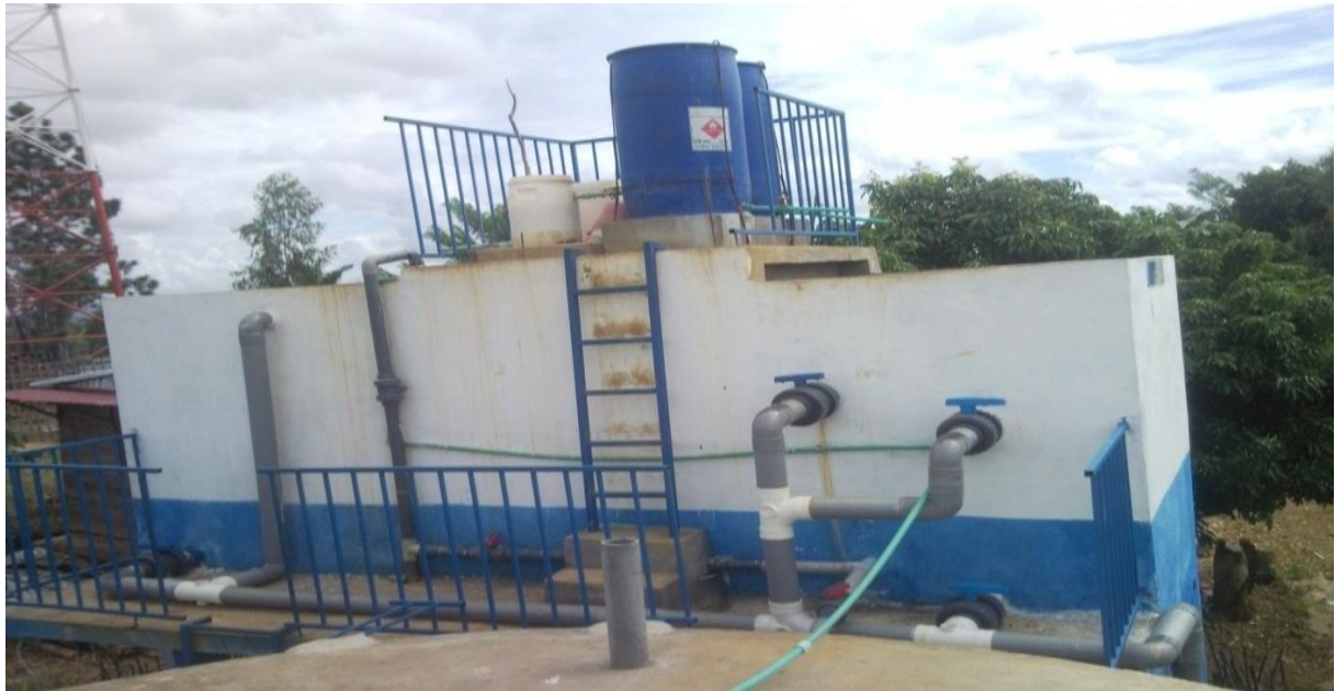
Photo n°4 : Bassin de traitement
