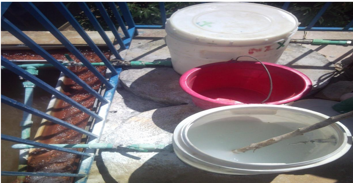
Photo n°6 : Petite cuve de dosage de la chaux
