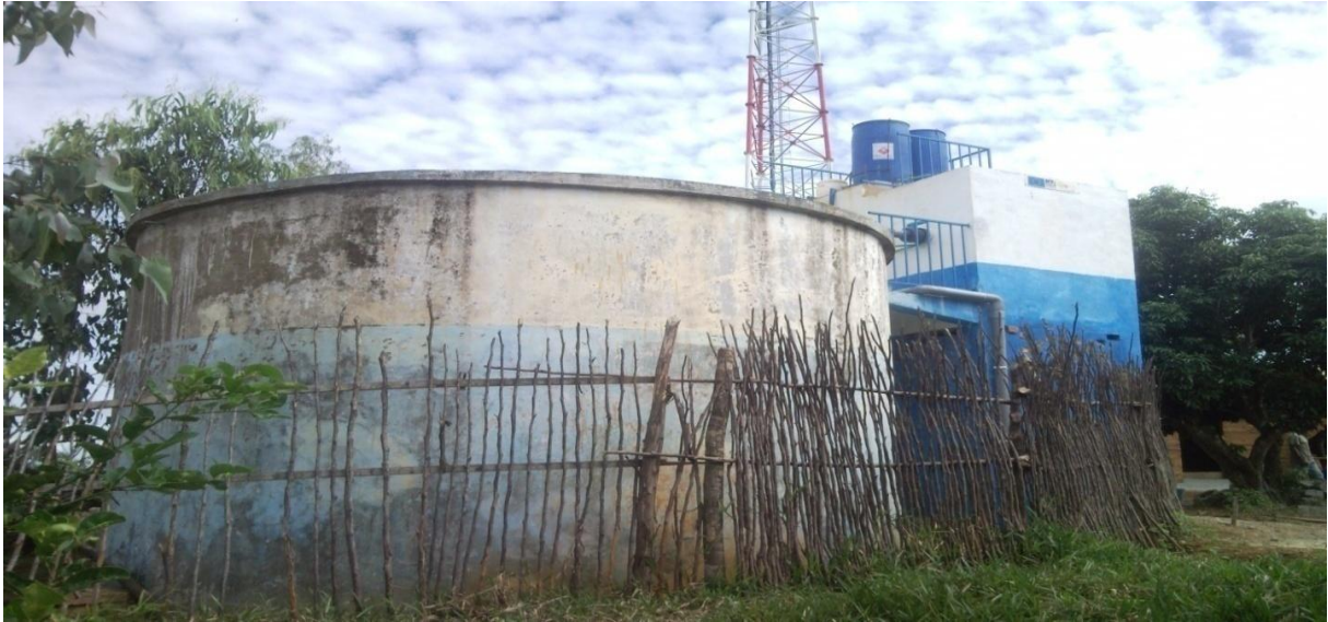
Photo n°3 : Réservoir de stockage
