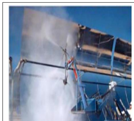
*Fig1.14 Nettoyage eau sous pression*
