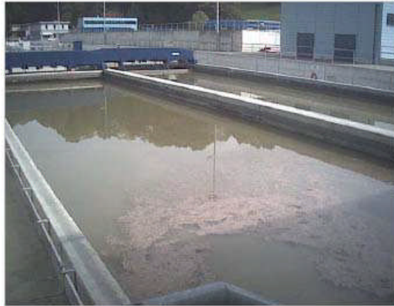
Figure 8 : Décantation primaire et flottation [62].
