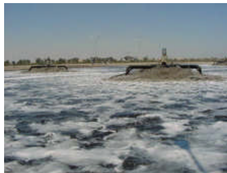
Aérateurs de surface amarrés
