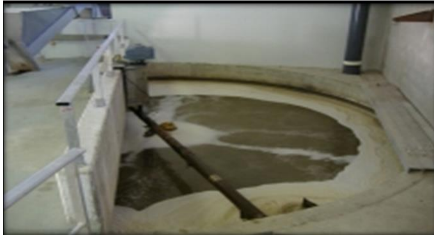
Figure II.3: Photo d'un dégraisseur-déshuileur [22]
