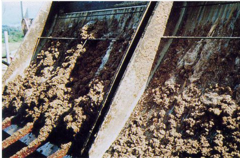
Figure II.1: Photo d'un dégrilleur [19]
