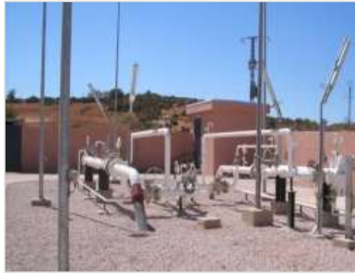
Fig. 2. 6 Poste de Coupure
