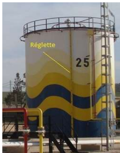
Fig. 2. 12 Bacs de stockage du mélange avec la règlette de lecture
