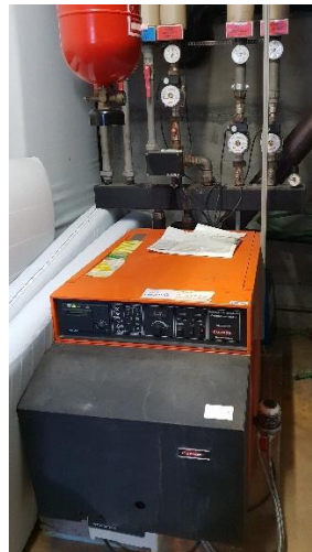
Figure 25 : Chaudière à mazout du chalet "Cordée"
