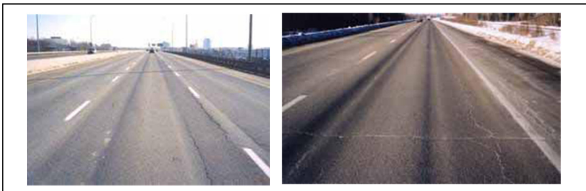
Figure 0.4 Illustration d'ornières observées sur les chaussées – sévérité élevée Source MTQ Info DLC Vol.10 No.1 (2005)
