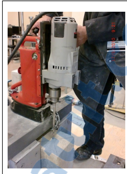
Figure 4.7 Perçage du trou dans un bloc de béton
