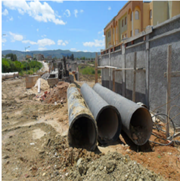
Photo 3-1 : La conduite d'adduction de diamètre 800 mm.
