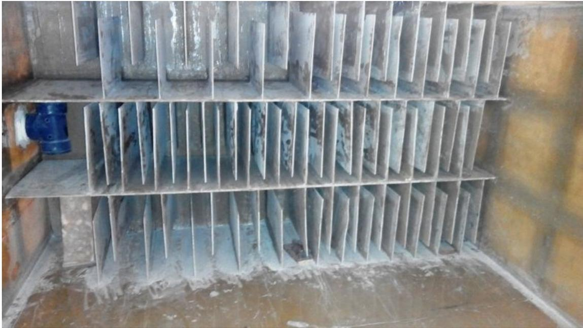
**Figure 78: Produit final: Le flocculateur dans le bassin**
