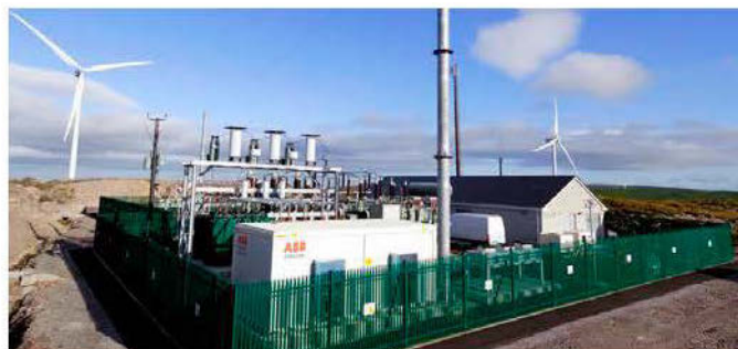
Figure 2 : Transformateur triphasé / photovoltaïque / moyenne tension PCS 6000 STATCOM [49]
