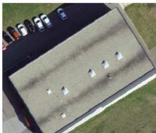
Image 3 toit du bâtiment actuel
