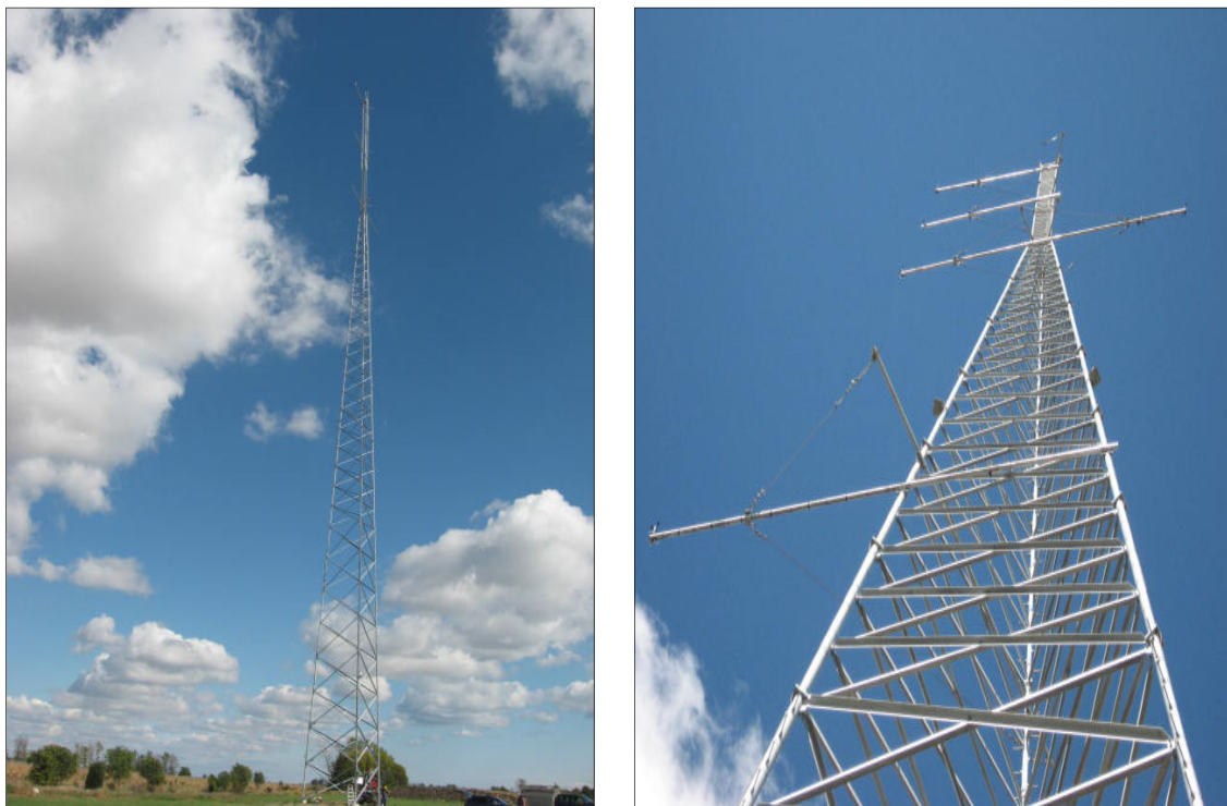
Figure 2.2 Mâts météorologique en treillis. Source : HéliMAX Énergie.
