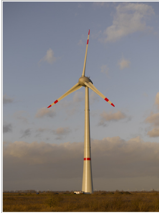
Figure 1.2 Éolienne Enercon E126, puissance nominale : 7MW, [4].
