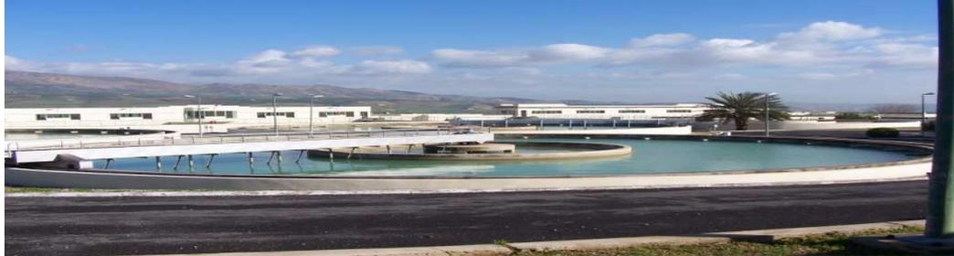
**Figure5: Un décanteur**
